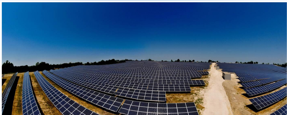
Centrale Solaire du SYCALA CAHORS (46)
