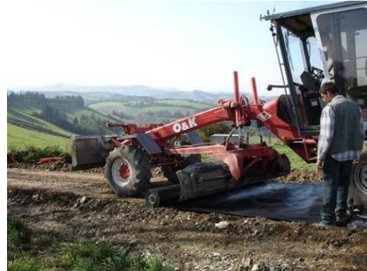
Pose du géotextile
