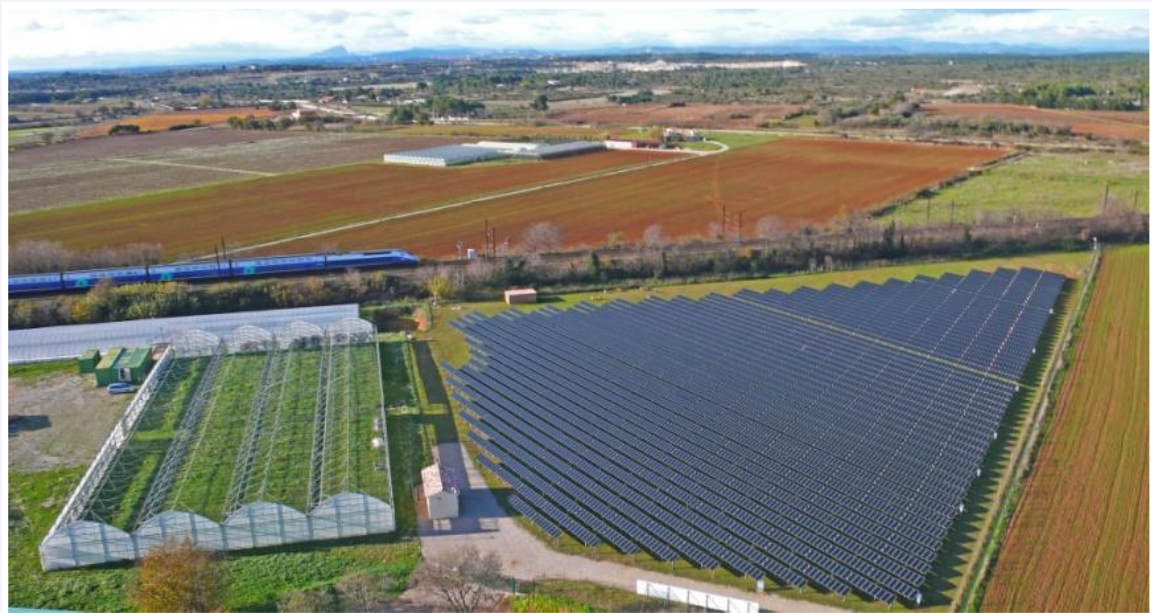
Centrale Solaire de LUNEL LUNEL (34)
