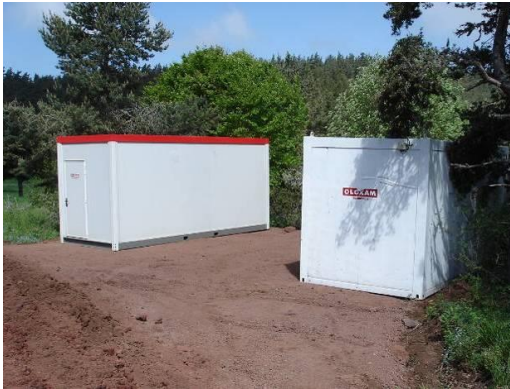
Vestiaires et bureaux de chantier
