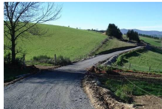
Mise en place du gravier
