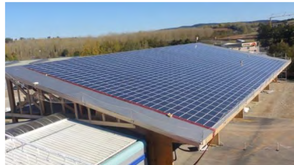
Bâtiment industriel RODEZ (12) Puissance électrique : 850 kWc Mise en service : Septembre 2011
