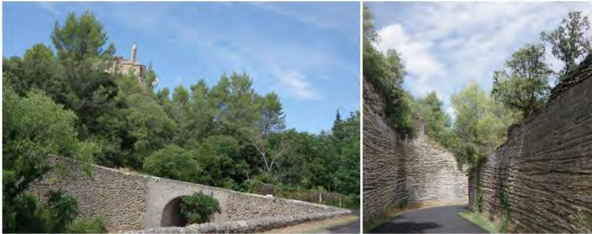
Figure 65 : Le bourg de Saumane-de-Vaucluse et la roche karstique calcaire
