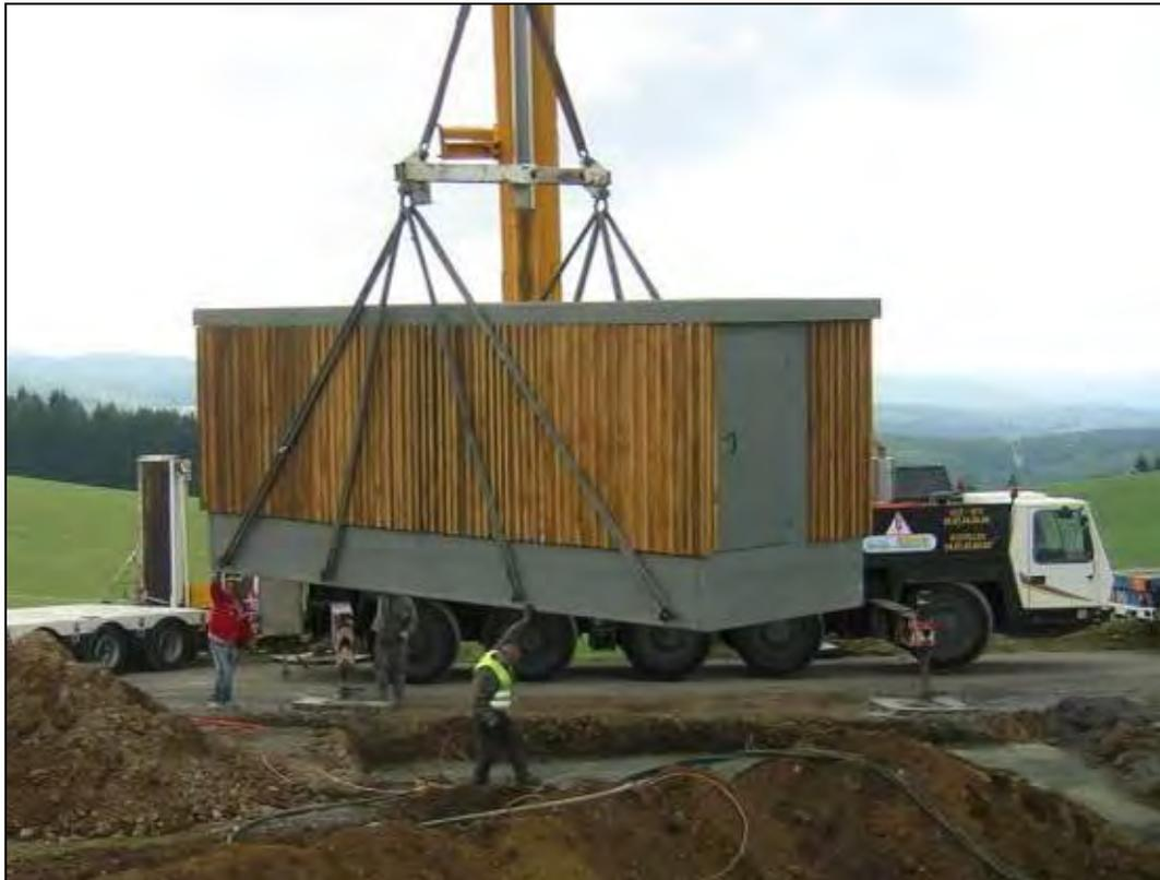
*Exemple de livraison d'un poste de transformation électrique sur un parc éolien*
