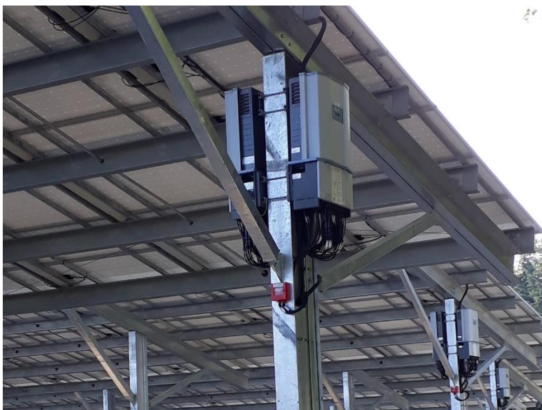
Figure 3 : exemple d'onduleur décentralisé
