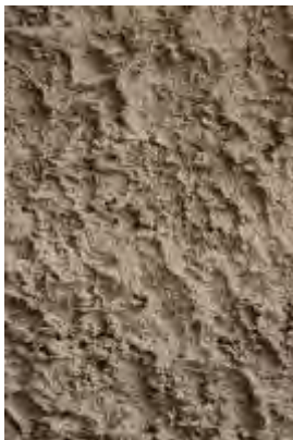
Enduit inadapté (matériau et texture)
