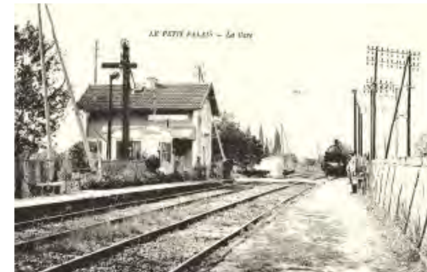
La gare de Petit-Palais desservant le sud du territoire
