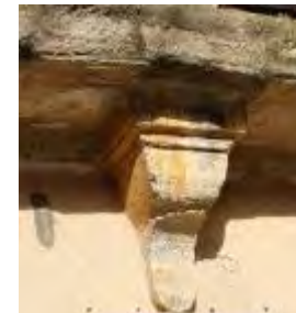
Console de balcon filant du 1er étage.
