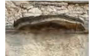
Console de balcon filant du 1er étage.
