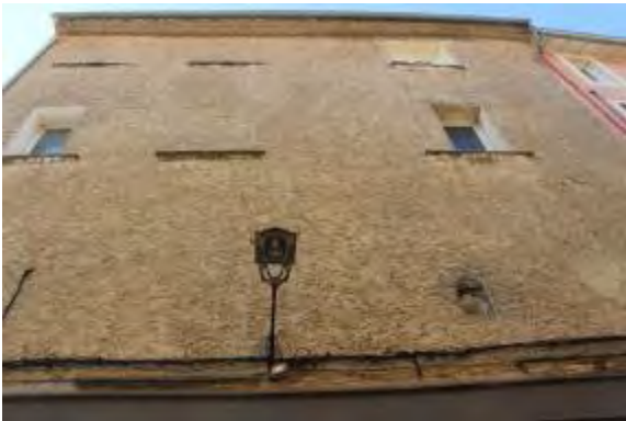
Enduit inadapté (matériau et texture)
