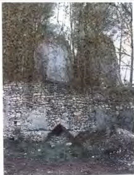
Vue arrière des deux fours circulaires construits sur un ancien four (Cliché ASPPIV, 2005)
