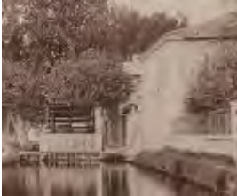
La fabrique de soie Pila
