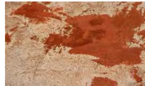
Badigeon d'ocre-rouge sur enduit plâtre CP 323 (rue Denfert-Rochereau)
