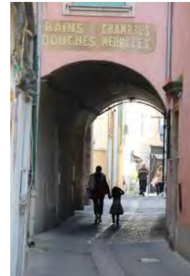
Vestiges de décors « fausses briques » sur pierre de taille (CP 860—Château Névens)
