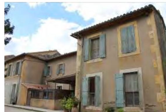
Façade principale au sud présentant de nombreux et grandes ouvertures
