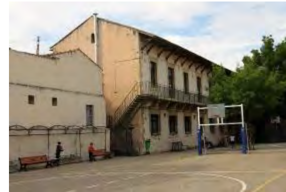
Ecole élémentaire du Centre, quai Clovis Hugues CP1636
