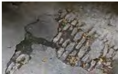
Calade sous un porche derrière de la Chapelle des Pénitents Bleus
