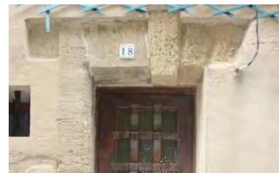
Avec une clef exacerbee malgré la modestie de l'ouvrage (clef traversante et tombante). Le piédroit et le linteau comportent une moulure en quart de rond.
