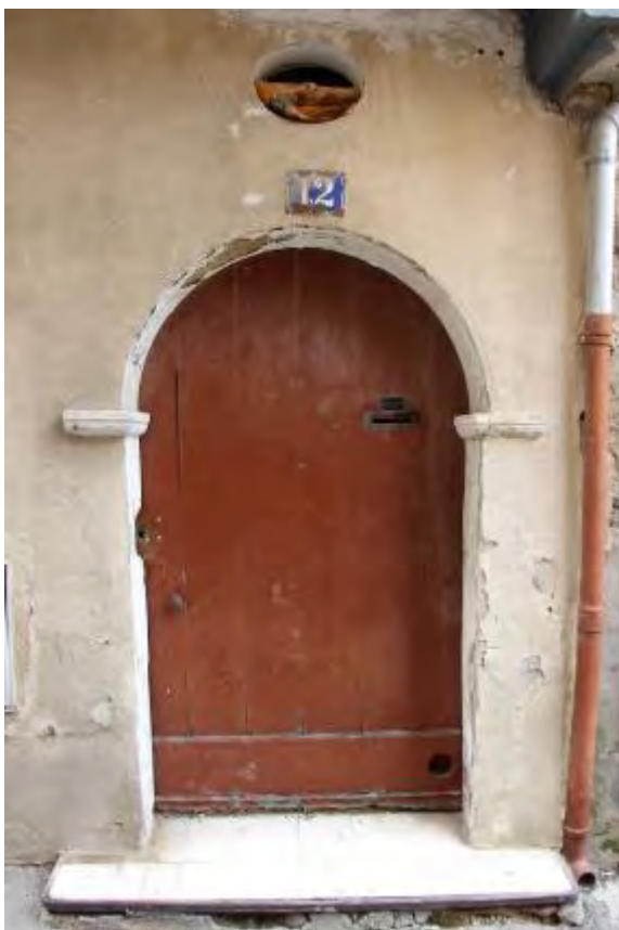
Celui-ci, surmonté d'un oculus, repose sur des sommiers de facture Renaissance.
