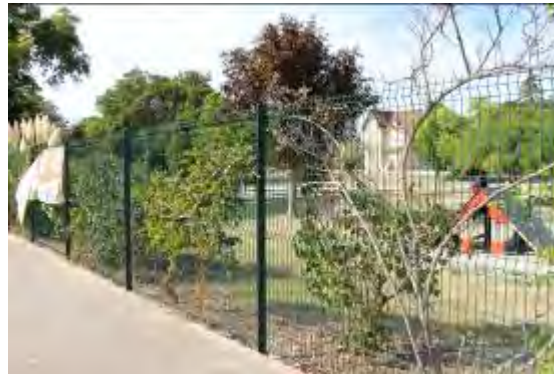
Clôture discordante du Parc Gautier
