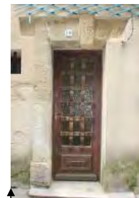
Avec une clef exacerbee malgré la modestie de l'ouvrage (clef traversante et tombante). Le piédroit et le linteau comportent une moulure en quart de rond.
