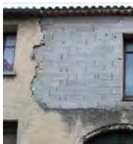
Ci-dessous une façade dont la maçonnerie an- cienne a été complétée en parpaings de béton et non enduite.
