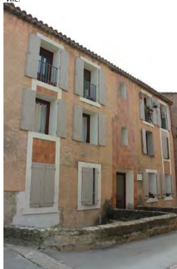
Ouverture de baie avec rebouchement au ciment artificiel au nu extérieur de l'enduit conservé
