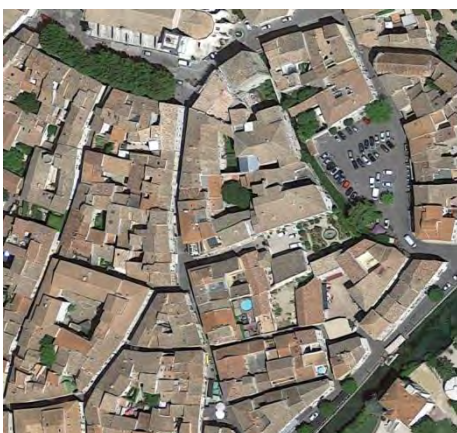
Vue aérienne de l'îlot ©2018 Google
