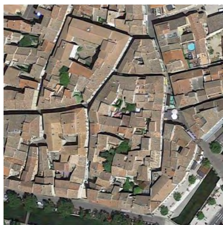
Vue aérienne de l'îlot ©2018 Google
