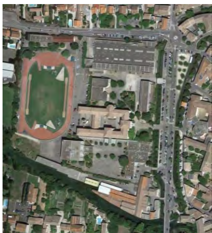
Vue aérienne de l'îlot ©2018 Google
