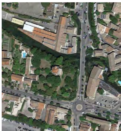
Vue aérienne de l'îlot ©2018 Google
