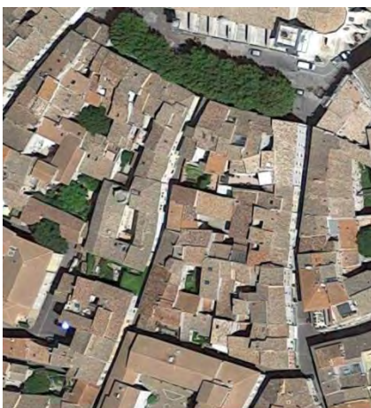
Vue aérienne de l'îlot ©2018 Google
