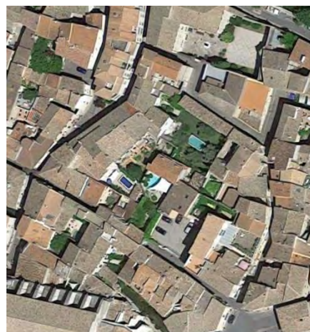
Vue aérienne de l'îlot ©2018 Google
