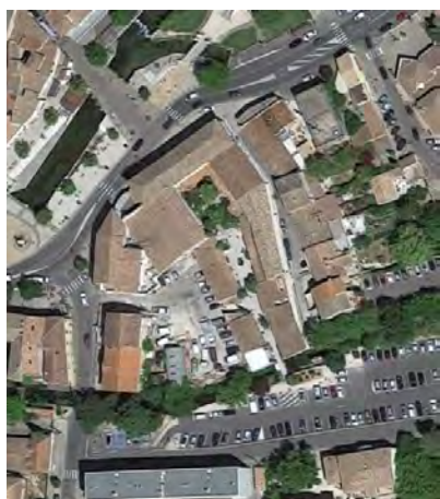
Vue aérienne de l'îlot ©2018 Google
