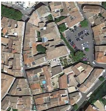
Vue aérienne de l'îlot ©2018 Google
