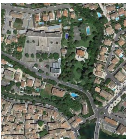
Vue aérienne de l'îlot ©2018 Google
