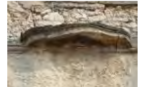
Console de balcon filant du 1 er étage.
