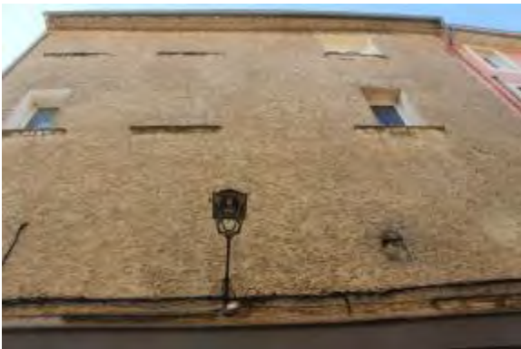
Enduit inadapté (matériau et texture)
