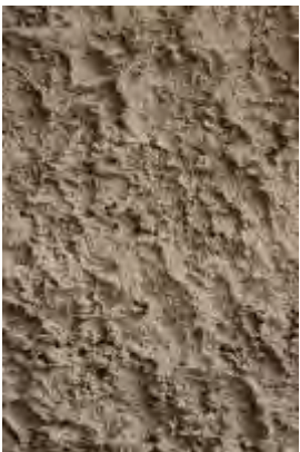
Enduit inadapté (matériau et texture)
