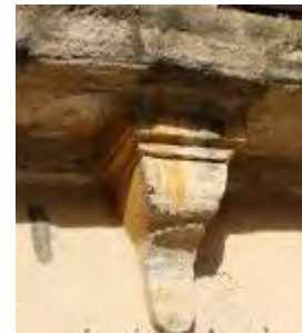
Console de balcon filant du 1 er étage.
