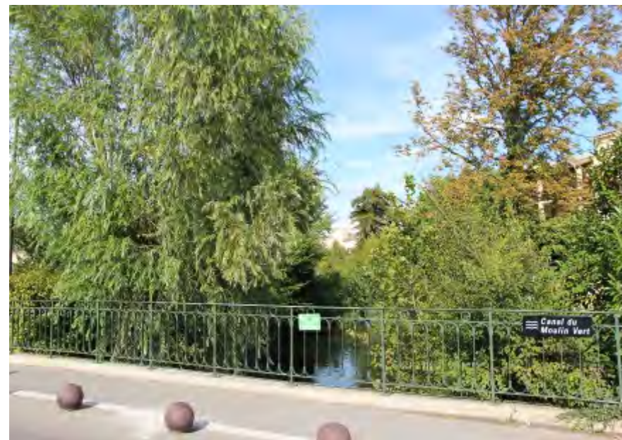
Franchissement du Canal du Moulin Vert en entrée de ville de la Route d'Apt
