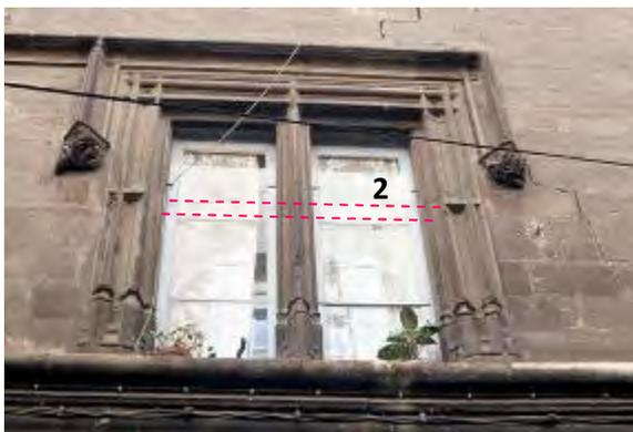
La présence d'une pierre de petite hauteur à l'emplacement de la baguette indique que la traverse (figurée en rose en 2) a été supprimée et les pierres retaillées a posteriori pour transformer les croisées en baies à meau.
