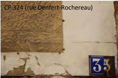
Au début du XX<sup>ème</sup> siècle, le ciment prompt naturel est apprécié pour ses qualités de prise rapide et de résistance, permettant la réalisation de décors sculptés. Bien souvent, il est employé pour réaliser l'enduit du soubassement. Ci-contre, il est associé au faux appareil au mortier de chaux texturé contrastant avec les bandeaux lisses et plus clairs.
