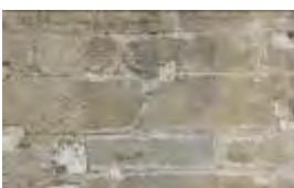
La pierre de taille constitue un parement, l'intérieur du mur est constitué d'un blocage.
