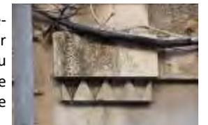
Le soubassement semble postérieur, ou restauré au ciment artificiel avec un effet de panneaux aux angles rognés en quart de cercle.
