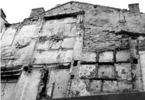
Ici les vestiges des pans de bois sont apparents entre les poteaux maçonnés.
