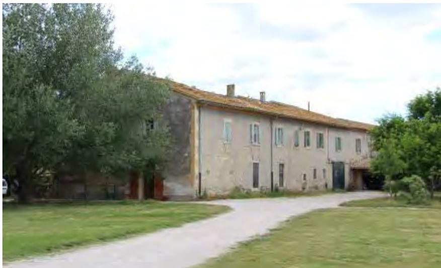
Façade arrière exposée au vent du nord s'en protégeant par de petites ouvertures
