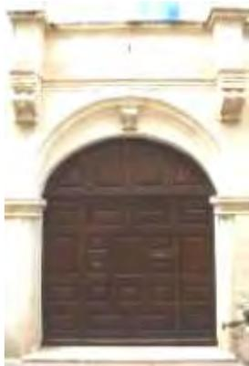
Porte refaite de style Renaissance avec une imposte à montants quasi rayonnants et deux panneaux semi(?) fixes latéraux. Panneaux rapportés sur âme de planches.
