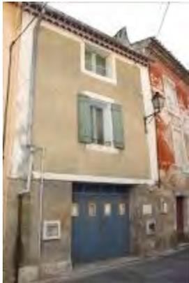
La partie supérieure de la façade est traitée avec un enduit de chaux texturé dont la teinte est dans la masse. Il est proche des enduits tyrolienne dans une teinte assez soutenue. Sa texture granuleuse en légère surépaisseur joue les contrastes avec les bandeaux d'encadrement lissés et badigeonnés en blanc. Les encadrements de fenêtre mais aussi un bandeau qui cerne
