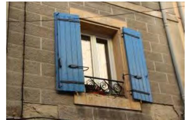
Les encadrements de fenêtre, chaîne d'angle et décor de gouttes sont réalisés au plâtre, avec un badigeon de teinte proche de la pierre de Pernes (?)
