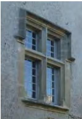
Croisée gothique tardif : surmontée d'un larmier mouluré, sur un appui isolé avec une moulure caractéristique, héritée des cordons filants (voir page suivante).
