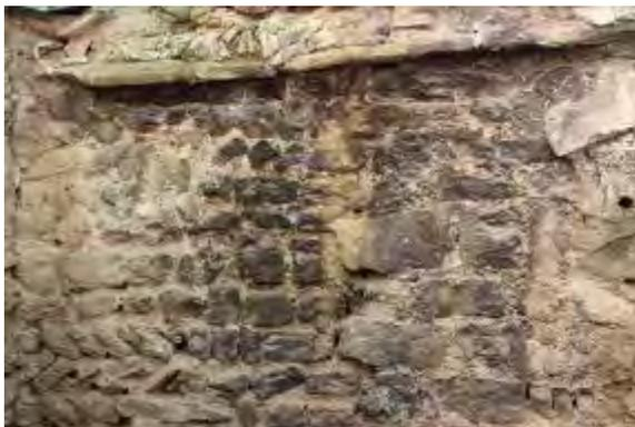
Vestige possible de mur avec pierre formant corniche avant couvertine de pierre cachant la toiture située en retrait (?) (mur sur rue, 2<sup>e</sup> étage) Suivant coupe ci-jointe de toiture de lauzes (extrait de « Charpentes méridionales »).
