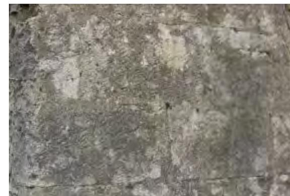
Pierre comportant une patte d'oie. Elle a été posée verticalement au lieu d'horizontalement, les incisions étant conçues pour que le mortier, le coulis de chaux ou le plâtre de scellement accroche mieux entre les lits de pierre.
