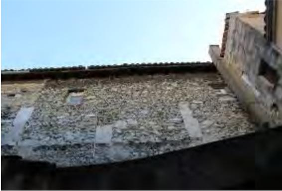
Ici ils sont visibles car restés enduits (au plâtre?) et les parties en pan de bois ont été supprimées pour être reconstruites en maçonnerie.
