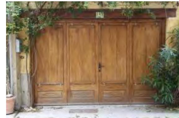
On trouve début XX<sup>ème</sup> siècle des devantures à imposte vitrée et vitrines fermées par des ais (volets portatifs), maintenus en haut par des panetons en fer et en bas par des boulons à clavette. Si le système de fermeture est plus sommaire, elles arborent aussi parfois des ornements (denticules, panneaux à rosace de style art déco).
