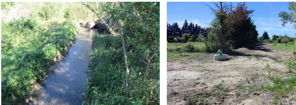
Figure 19 : Illustrations de l'évolution du fossé en 2020 (à gauche), busé et enterré en 2023 (droite). Photos sur site : Naturalia
