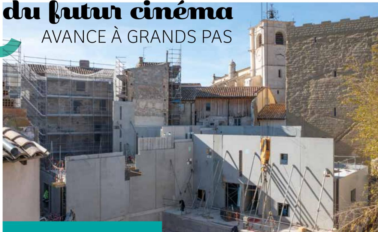
**2** 023 marque, pour les travaux de construction du futur cinéma, un grand tournant. Après les phases de déconstruction et de fouilles archéologiques, ce chantier hors norme a fait place, à l'automne dernier, à l'incontournable étape des fondations. Un chapitre désormais achevé, qui en a ouvert un autre en début d'année : celui de l'élévation des prémurs. Gros plan sur l'avancée d'un chantier aux multiples facettes.
